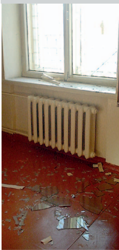
▼ Разрушение стеклянного окна.
